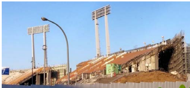
解体中の国立競技場
